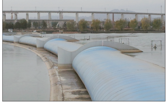
〈그림 5〉 Yongding강에 설치된 다양한 러버보의 형태
