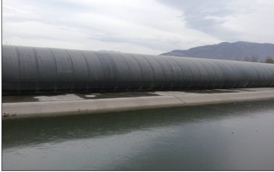
〈그림 5〉 Yongding강에 설치된 다양한 러버보의 형태
