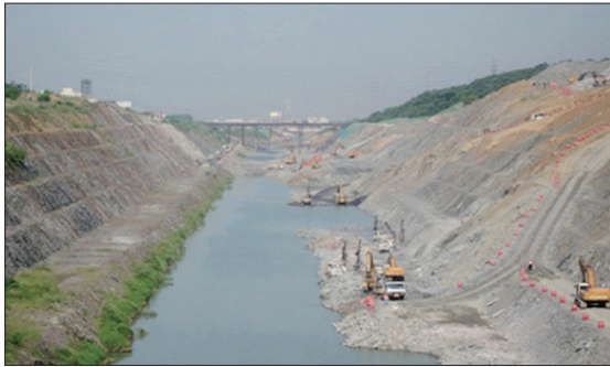
(그림 6) 방수로 공사 예(골포천)
